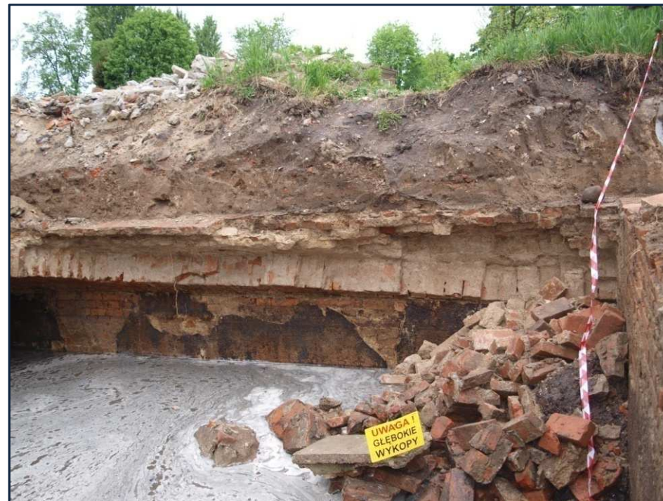
Widok na wnętrze pomieszczenia szaletu po zawaleniu się stropu
